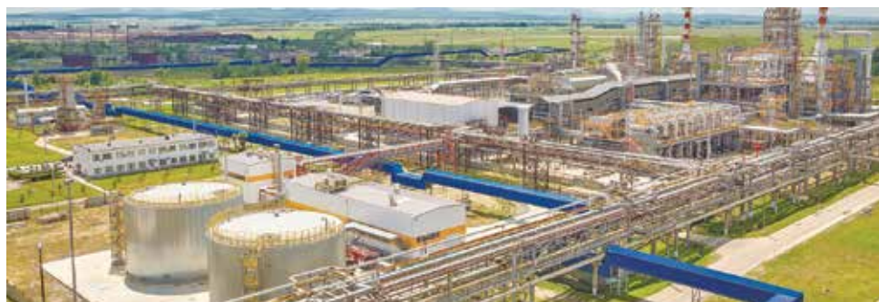
Благодаря ремонтным работам удалось увеличить выход вакуумной дизельной фракции на 0,55%, вакуумного газойля – на 2,04%, бензина – на 0,09%.
